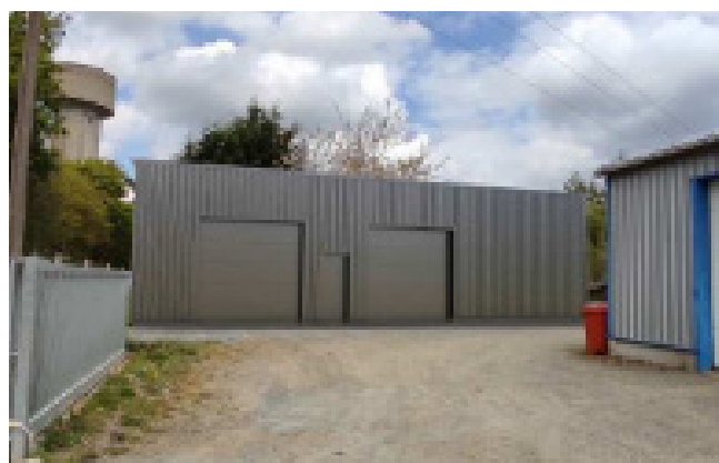
Photo du hangar de stockage – zone de Kéribot (5)
