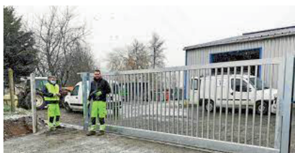
Remplacement portail services techniques
