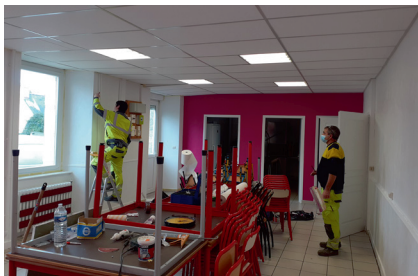
Rénovation réfectoire cantine école privée
