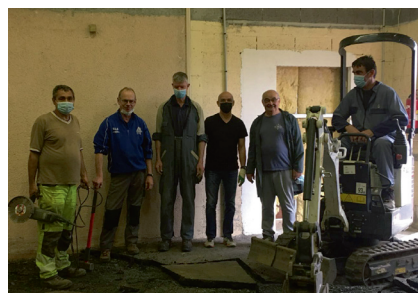
Début travaux future salle des associations à la salle omnisports
