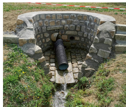
Création et maçonnerie déversoir site de l'Isle
