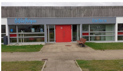
Rénovation ravalements garderie/ médiathèque
