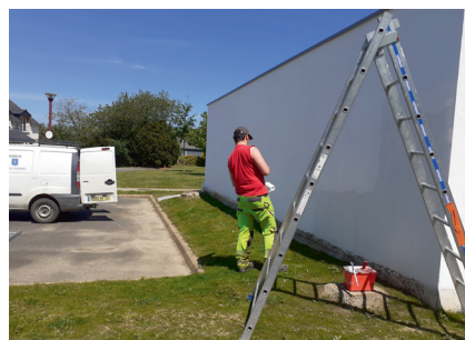
Renforcement mur d'enceinte derrière médiathèque
