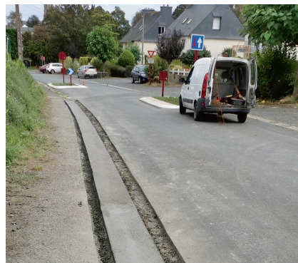
Remplacement bordures de caniveaux place de l'église et rue de Cornouaille
